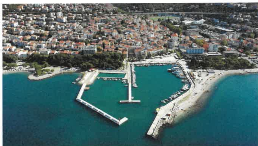
Završeni radovi 31. srpnja 2021.
