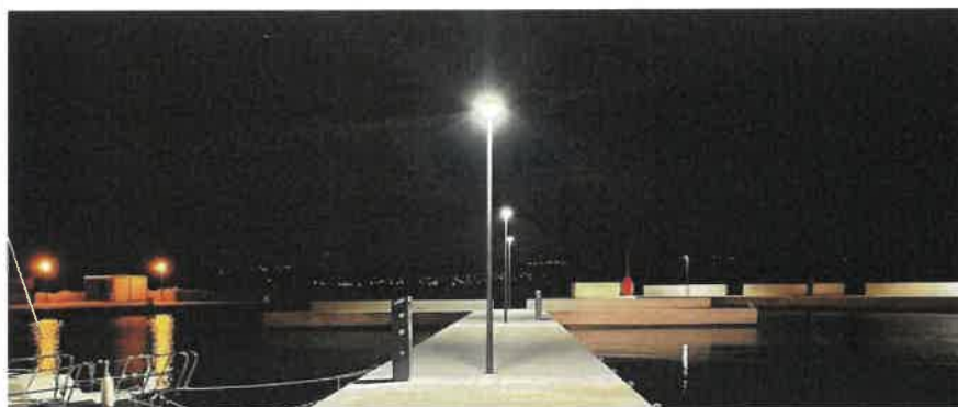
Izgled novopostavljenje LED rasvjete na dograđenom dijelu Male palade u studenom 2021.
